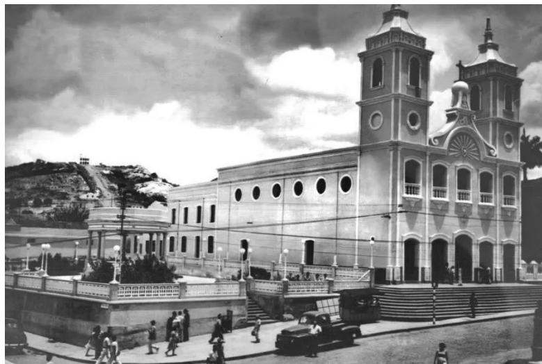
Figura 6 – Catedral de Nossa Senhora das Dores após a reforma
