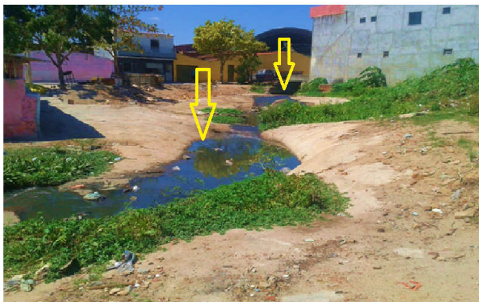
Figura 04: Um das entradas que dá acesso aos Caldeirões totalmente aberta
