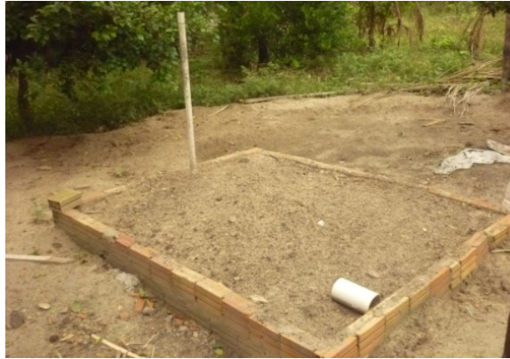
Figura 7 – Construção da Tecnologia Social Filtro Lento de Areia para purificação da água, (Pará)
