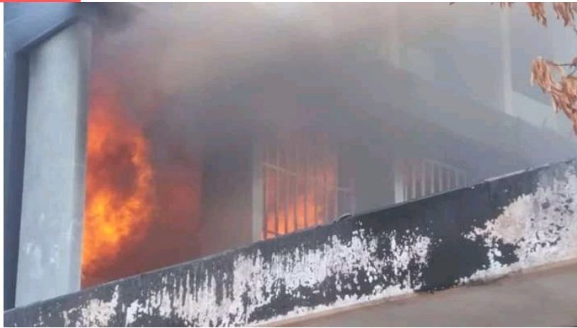
Figura 6: Incendio en la UDO
