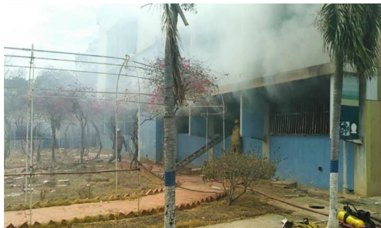
Figura 3: Incendio de la biblioteca central UDO.
