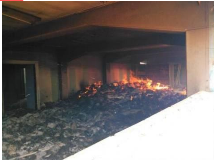
Figura 2: Incendio de la biblioteca central UDO
