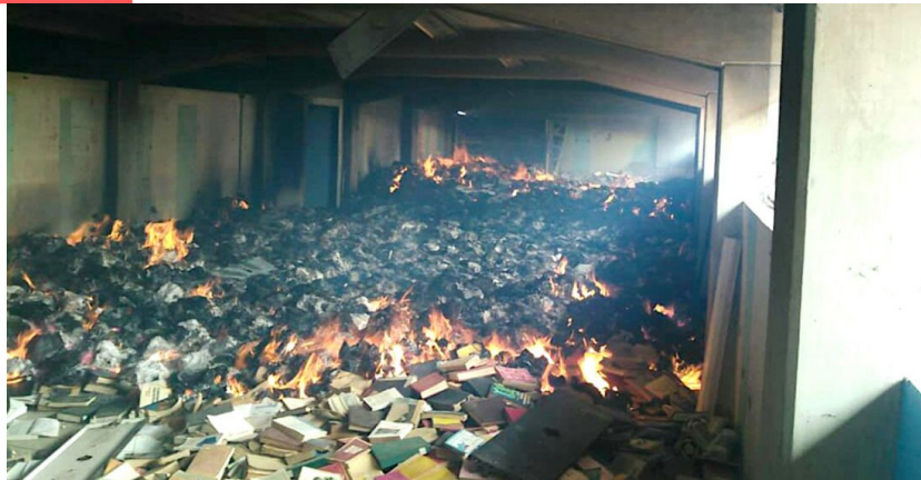
Figura 4: Incendio de la biblioteca central UDO.
